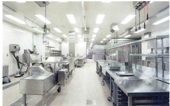
写真2 EDS-プレバレーションエリアでの利用とソックダクト及び照明具
