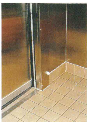
写真3 プレハブ冷蔵庫内の床仕上げ
