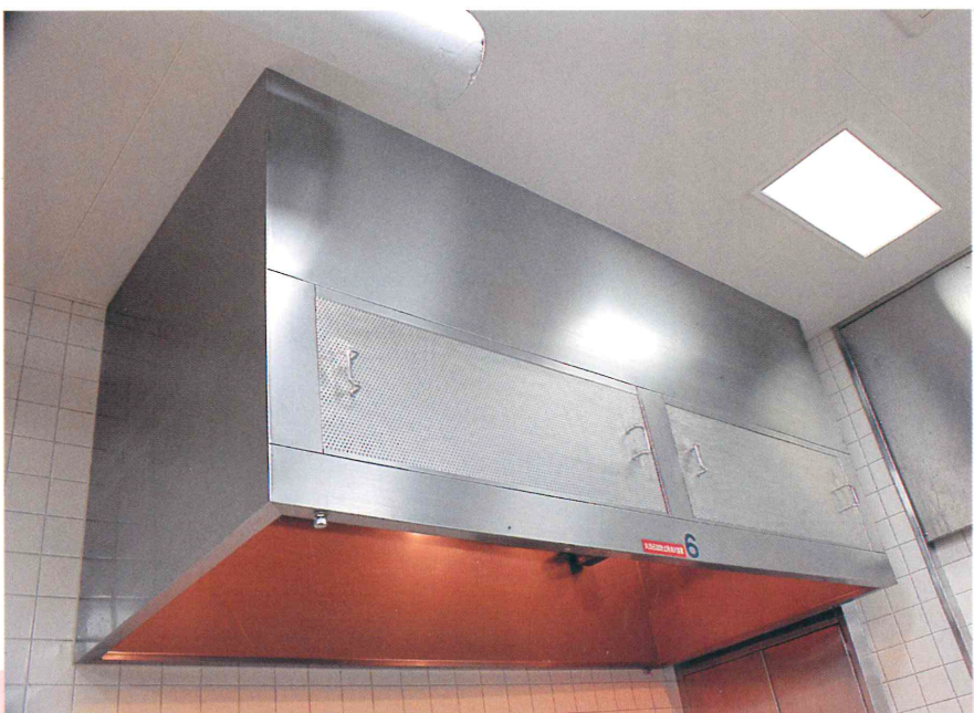
写真7 排気に加え、フードの前より給気を行うことにより作業エリアの温度を下げる
