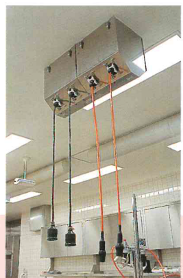
EDS/電気や圧縮空気の供給を昇降式ドラムリールにて行う
