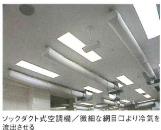
写真2 EDS-プレバレーションエリアでの利用とソックダクト及び照明具
