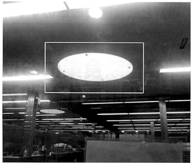
写真4 天窓の設置された厨房
